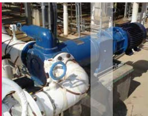
La pompe ED est une pompe volumétrique auto-amorçante idéale pour le dépotage de cuve de MDI. Nous recommandons de positionner la pompe au centre de la ligne afin d'assurer un transfert et une vidange efficace.
