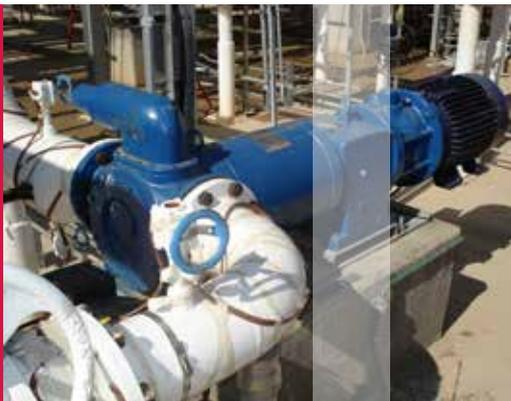
La bomba ED es una bomba de cebado automático que es útil y adecuada para la descarga de cisternas de MDI. Recomendamos colocar la bomba en la línea central con el fin de hacer mucho más fácil el manejo y el drenaje.
